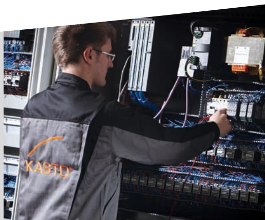
Remise en état.
